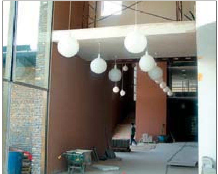
La instal·lació elèctrica, de serveis i de seguretat està enllestida
