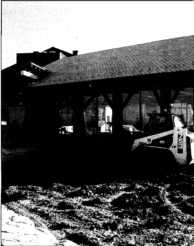
Obres del nou hotel, al golf de Fontanals. S'inaugurarà aquest desembre
