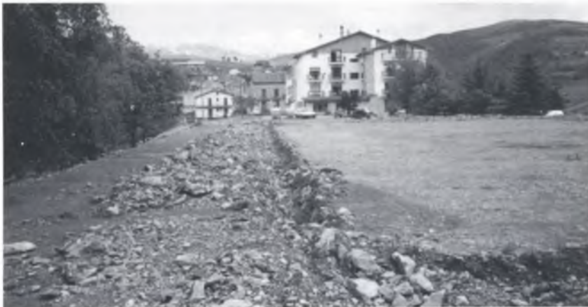
Solar aon han començat les obres del nou Poliesportiu.
