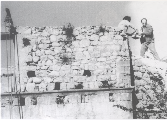
Treballs de restauració a Santa Bàrbara de Pruneres (1976).
