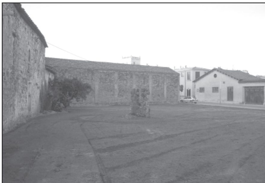
Imatge del solar que provisionalment serà pàrquing
