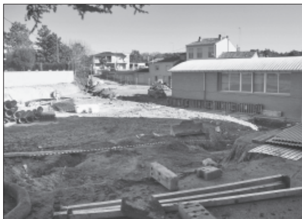
El solar on s'està fent l'ampliació de l'escola
