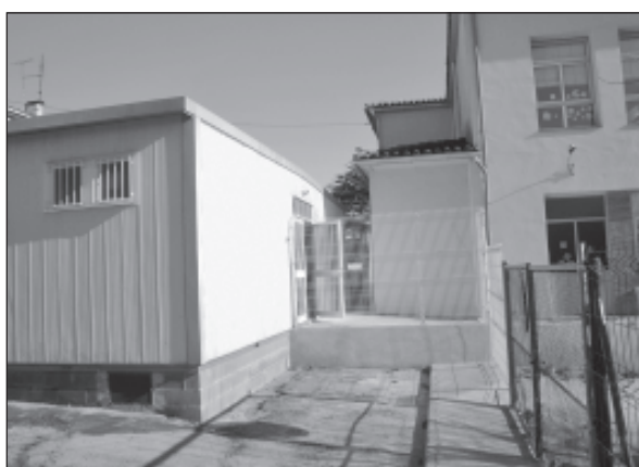
El mòdul prefabricat al costat de l'edifici
