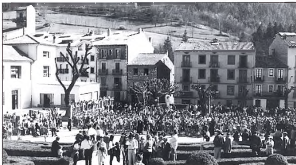
◀ "Concentració d'armats al Planet"
