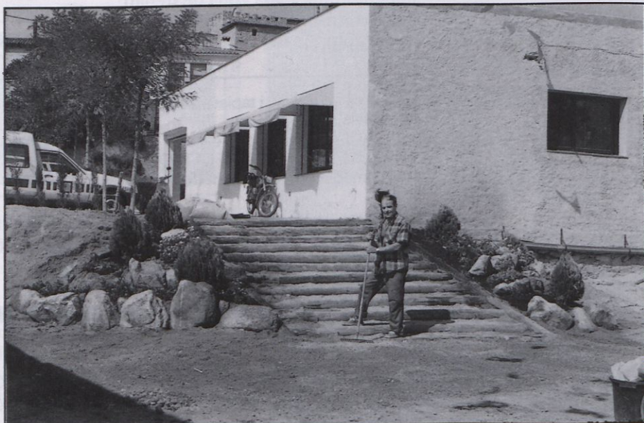
Les escales acabades de construir, que porten a l'envelat.
