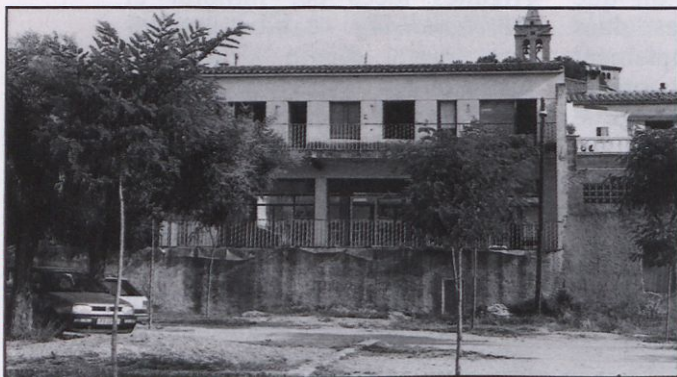
Ca la Rafela, en obres.
