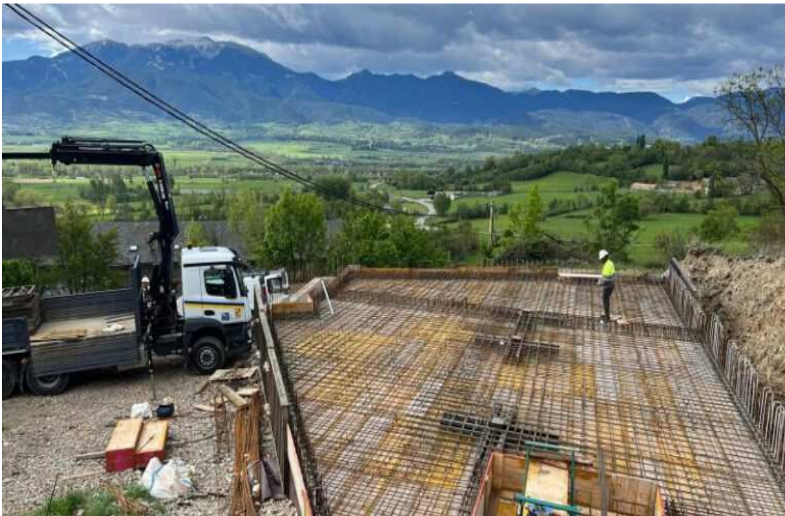
Una de les quatre parcel·les on s'està edificant un casa./M.F.
