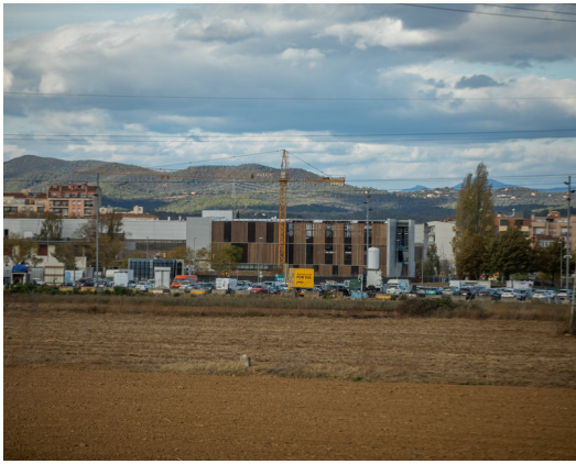
Terrenys de Salt on es construirà el futur Campus de Salut QUIM PUIG.
