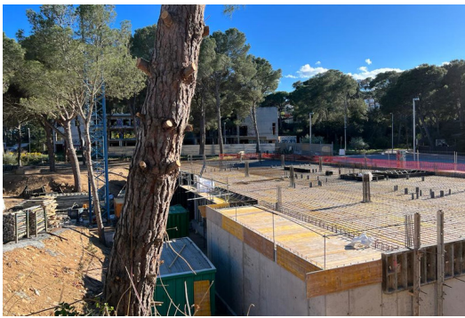
L'edifici plurifamiliar que s'està construint a Pals ACN.
