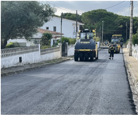
Treballs d'asfaltatge en un carrer de l'Escaló, obres fetes temps enrere AJ: L'ESCALA.
