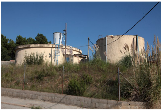
Dipòsits d'aigua de l'urbanització Les Comes i Vallcanera JOAN SABATER.
