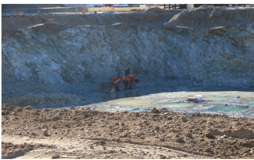
Una màquina treballa en els fonaments del nou edifici G. VILÀ (ACN).
