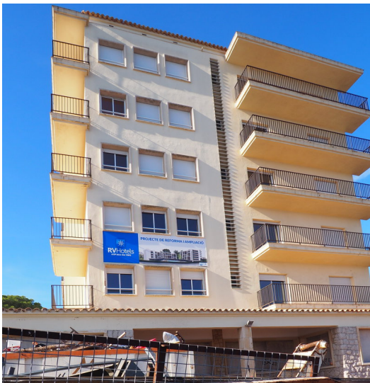
L'antic hotel Nieves Mar, en una imatge presa a l'any 2017 quan es començaven les obres. J.P.
