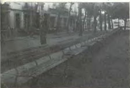
Instalación de bancos en diferentes lunetas de la población
