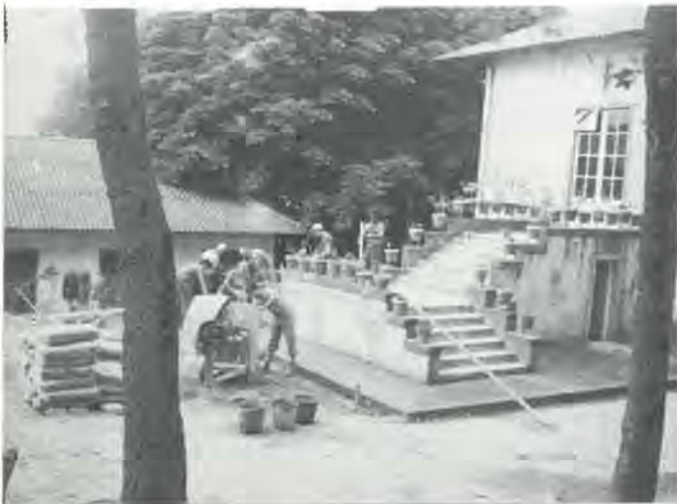
Obres en els pavellons dels "Campaments"
