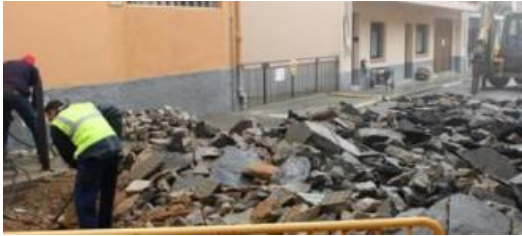
Arbúcies inicia les obres de millora de l'últim tram del carrer Sorrall
