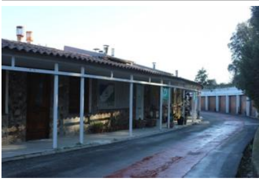
Els treballs que s'han portat a terme amb morter
