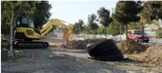
Operaris treballant a l'aparcament
