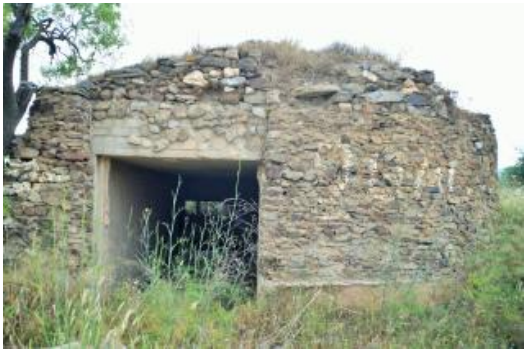
Un dels búnquers del terme de Garriguella.
