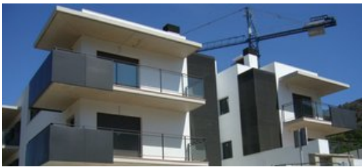
Els pisos de protecció oficial s'han fet a la zona de la Sorra, a la carretera de Cadaqués Foto: M.V.
