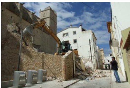
Una imatge de l'inici de l'enderroc dilluns de l'edifici de la Pluma. Foto: EL PUNT.
