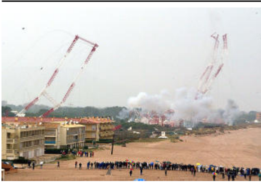
La demolició de les impressionants antenes va durar escassament cinc segons
