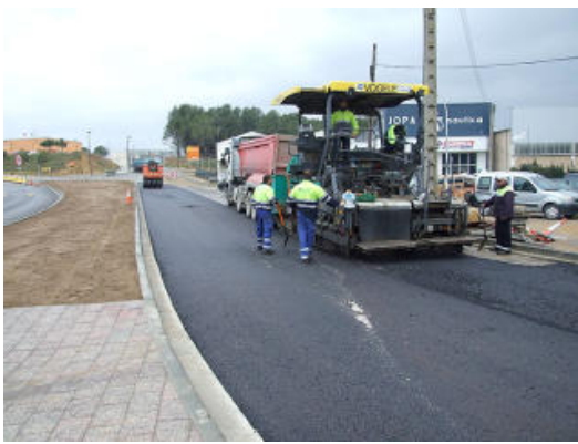
Les màquines, asfaltant.<br/>
