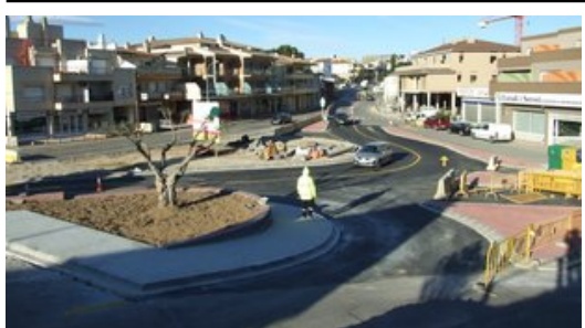
La rotonda que s'està construint a l'accés sud.
