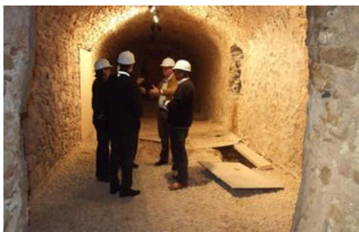
Una visita d'obres a l'Alfolí de la Sal.
