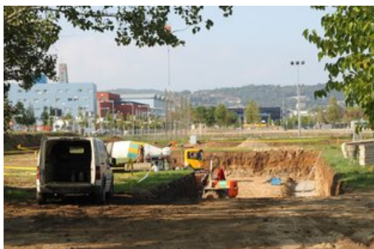
Les obres de la nova comissaria de la policia municipal que s'està construint al carrer Pla de Salt Foto: J.N.
