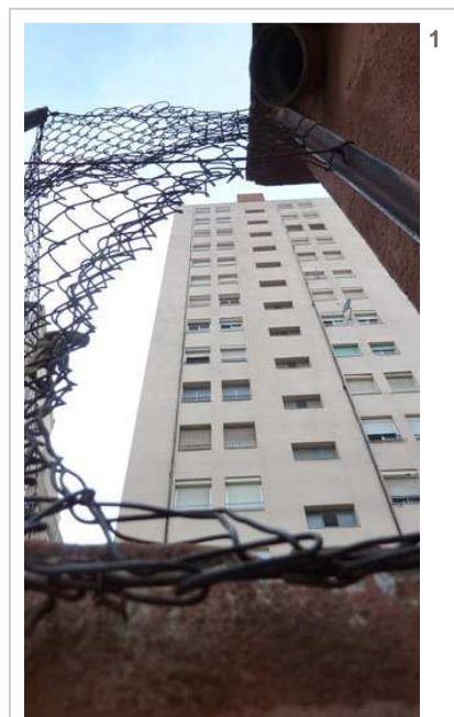
El forat per on va poder fugir el lladre de l'edifici conegut com a 'gratacels' Foto: Ò. PINILLA.
